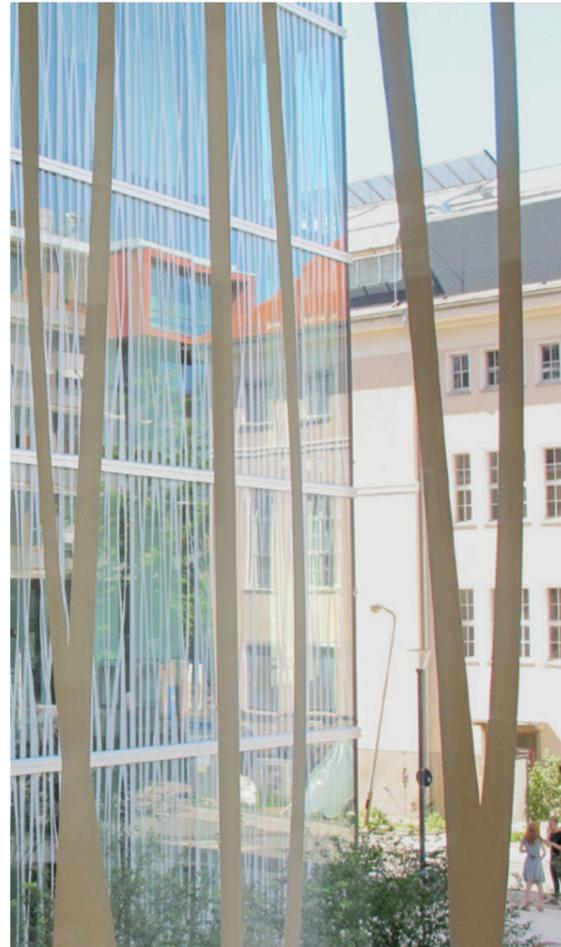
Dem Architekturbüro Staab Architekten ist es durch die spezielle Gestaltung der für die Fassade verwendeten Sonnenschutzverglasung gelungen, dieses Risiko auf ein Minimum zu reduzieren. Die helle Bedruckung der Gläser mit einem organisch anmutenden Muster erfüllt einerseits die geltenden Vorgaben bezüglich der Sonnenschutzfunktion und hält aufgrund ihrer durchdachten Gliederung das Sichtfeld nach draußen frei, andererseits ist sie für Vögel deutlich als Hindernis zu erkennen.
