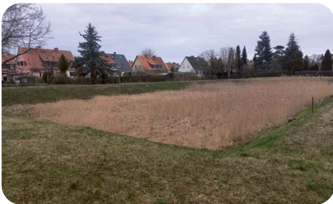
Abb. 25: Regenrückhaltebecken Altglienicke, Treptow-Köpenick. Foto: A. Poustka
