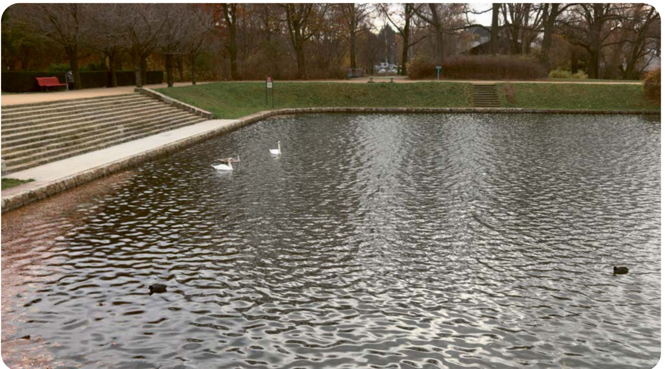
Abb. 84: Betonuferverbau am Blümelteich in Tempelhof-Schöneberg. In das Gewässer geratene Amphibien finden hier kaum eine Ausstiegsmöglichkeit. Foto: N. Gamrath
