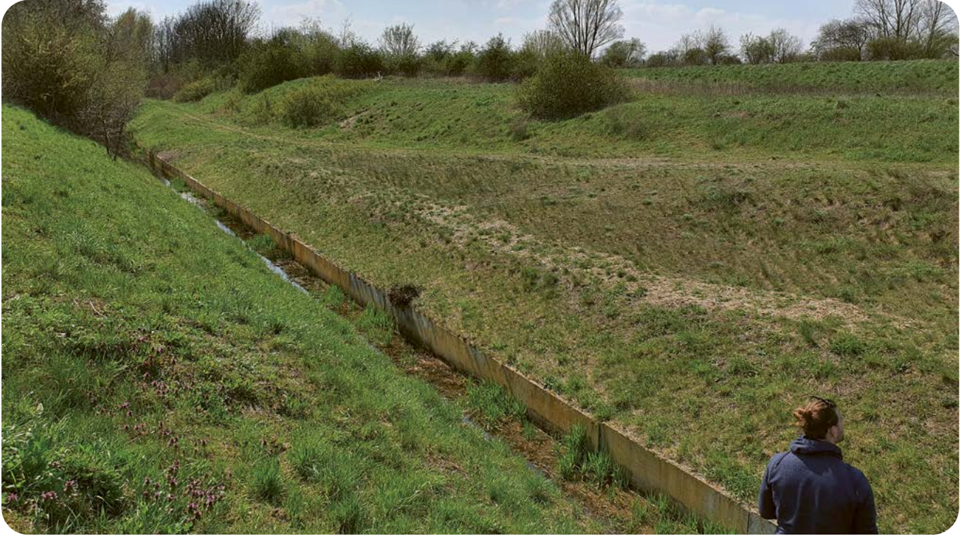
Abb. 83: Millionengraben in Lichtenberg, über lange Strecken mit U-Profilen verbaut, die für Amphibien unüberwindbar sind. Gräben dieser Art wirken als Barrieren und zerschneiden so das Habitat. Foto: S. Bengsch
