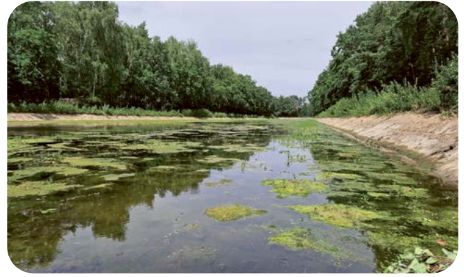
Abb. 22: Sickerbecken im Wasserwerk Spandau. Foto: A. Poustka
